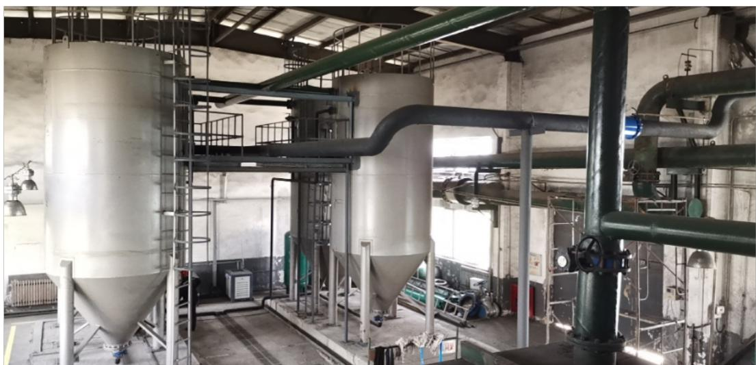
活性砂过滤器是一种集絮凝、澄清、过滤为一体的连续过滤设备, 普遍应用于饮用水、工业用水、污水深度处理及中水回用处理领域。系统采用升流式流动床过滤原理和单一均质滤料, 过滤与洗砂同时进行, 能够24小时连续自动运行, 无需停机反冲洗, 巧妙的提砂和洗砂结构代替了传统大功率反冲洗系统, 能耗极低。系统无需维护, 管理简便, 可无人值守。活性砂过滤系统由混凝土滤池, 滤砂导向装置, 过滤器组件, 洗砂器, 进水管道, 空气提升管, 滤液出水管道和冲洗水出水管等组成。内部过滤单元与相应管道间采用柔性连接。压缩空气经控制柜, 通过空气软管与过滤器顶部连接。滤池底部的滤砂依靠位于过滤器中心的空气提升泵的提升到达位于过滤器顶部的洗砂器, 通过紊流作用使脏颗粒从滤砂中分离出来, 杂质通过清洗水出口排出, 清洗后的滤砂回落到砂床。常州过滤器厂家电话活性炭过滤器主要利用含碳量高、分子量大、比表面积大的活性炭有机絮凝体对水中杂质进行物理吸附。
